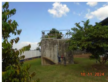
ภาพที่ 2-19 บ่อแยกน้ำ/น้ำมัน (Oil Separator)
